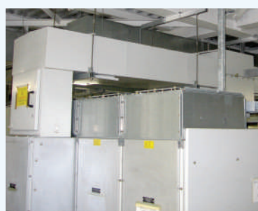
Szynoprzewody trójfazowe, prostokątne w izolacji powietrznej Uniwersalność i dopasowanie do potrzeb
