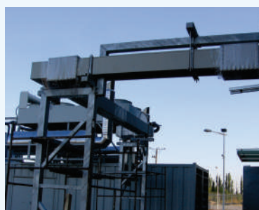
Szynoprzewody dystrybucyjne w izolacji stałej Wysoka odporność na czynniki zewnętrzne
