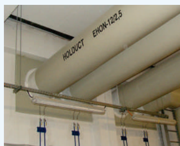
Szynoprzewody trójfazowe, okrągłe w izolacji powietrznej Najwyższa korzyść ekonomiczna
