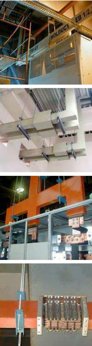
**Szynoprzewód typu Eurobar jest osłoniętym, samonośnym, chłodzonym naturalnie przewodem szynowym niskiego napięcia.**
